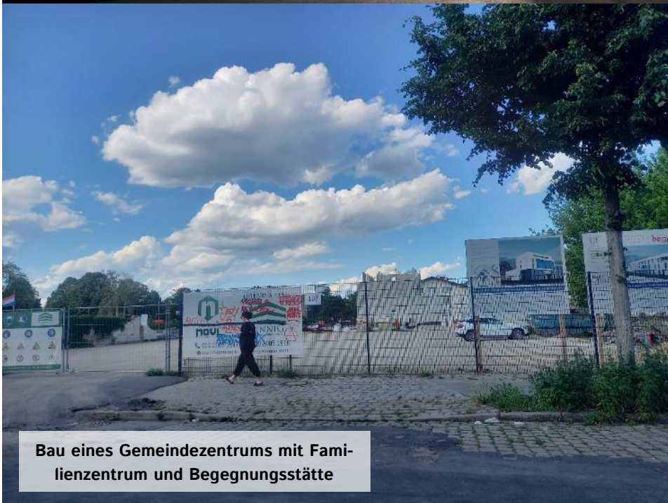
Bau von Wohnungen
